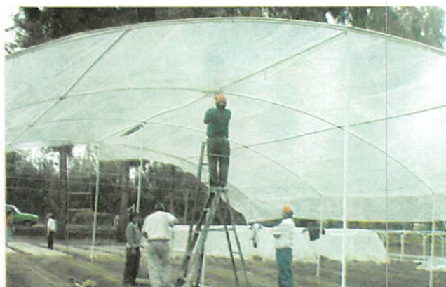
Construcción de Macrotúneles
