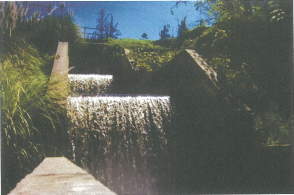
Fotografía N.- 12 Obras especiales para una mayor eficiencia en la distribución del riego dentro del sistema.
